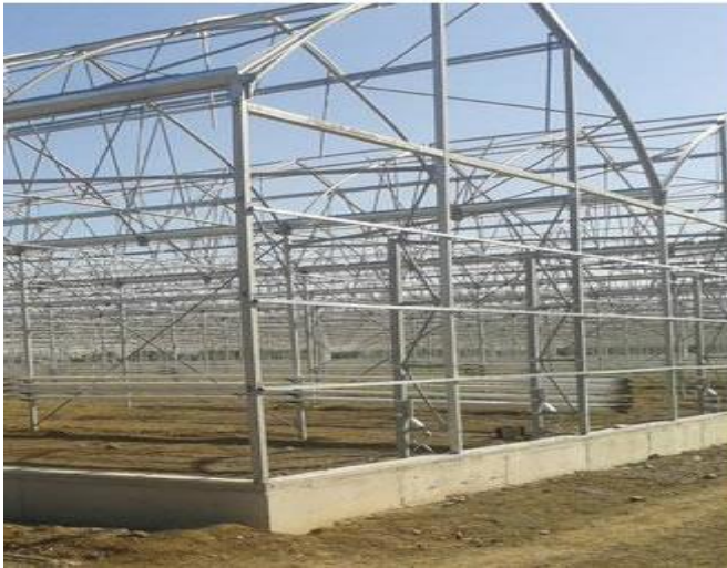
Şekil 1.14. Çevre Temel ve Yan Perde Beton
