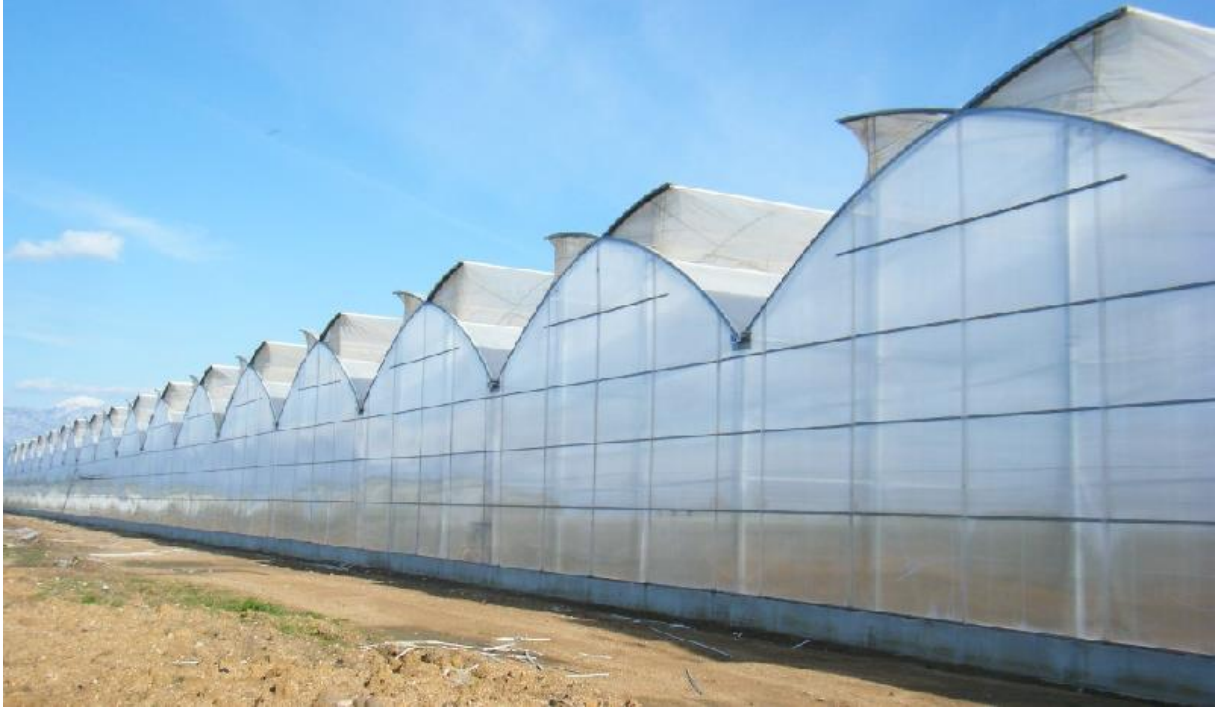
Şekil 1.10. Gotik Tip Modern Teknolojik Sera Örneği
