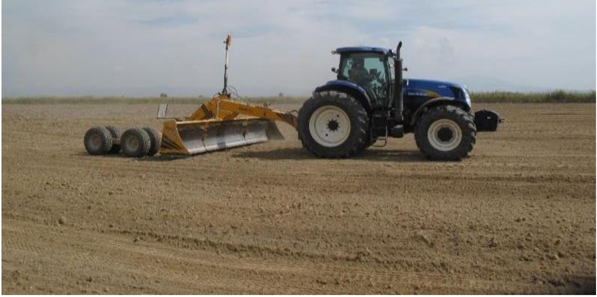
Şekil 1.11. Sera Alanı Arazi Tesviyesi
