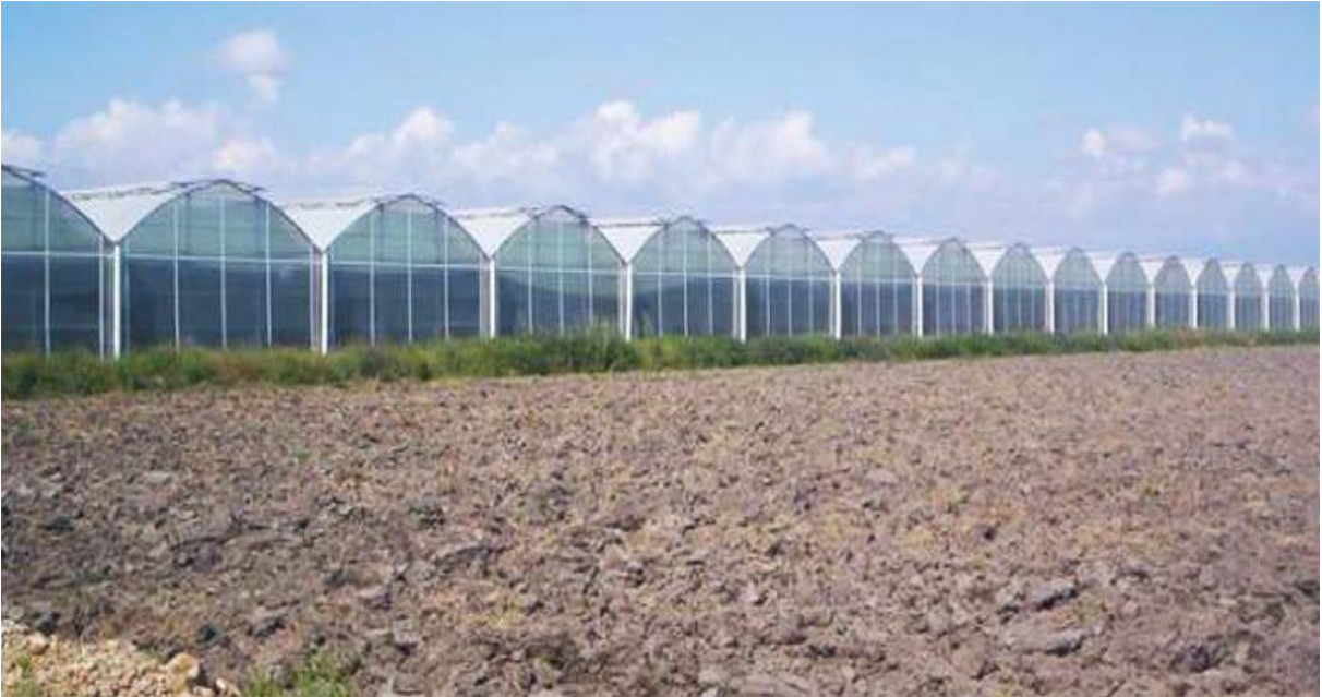
Şekil 1.21. Polikarbon Sera Yan Duvarları
